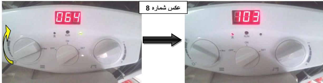
**۱-۲. برای افزایش مقدار حداکثر شعله گرمایش** : کلید چرخان تنظیم درجه حرارت آب گرم مصرفی را در جهت عقربه های ساعت، از ساعت ۱۲ به سمت راست در جهت پایین بچرخانید تا مقدار حداکثر شعله گرمایش افزایش بیابد . (طبق عکس شماره ۹)
