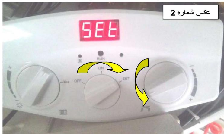
مرحله اول : تنظیم حداقل (مینیمم) ارتفاع شعله : کلید چرخان تنظیم درجه حرارت سیستم گرمایش (کلید سمت چپ) را تا انتهای به سمت چپ بچرخانید ، سپس دستگاه وارد حالت تنظیم حداقل ارتفاع شعله می شود و چراغ سمت راست روشن می گردد و عددی که معرف مقدار مینیمم شعله می باشد ، بر روی صفحه نمایشگر LED به حالت چشمک زن ظاهر می شود.(طبق عکس شماره ۳)
